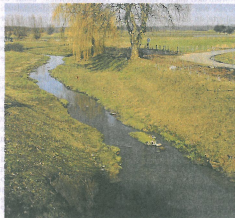
Der Heerener Mühlbach fließt nach dem Abschluss der Renaturierung nicht mehr über Beton-Sohlschalen. ■ Foto: Milk
