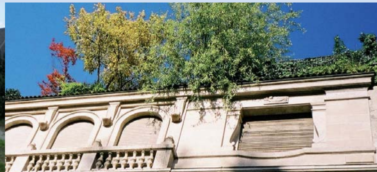
Begrünte Dächer tragen erheblich zur Wärmedämmung und zur Kühlung des Stadtklimas bei.
