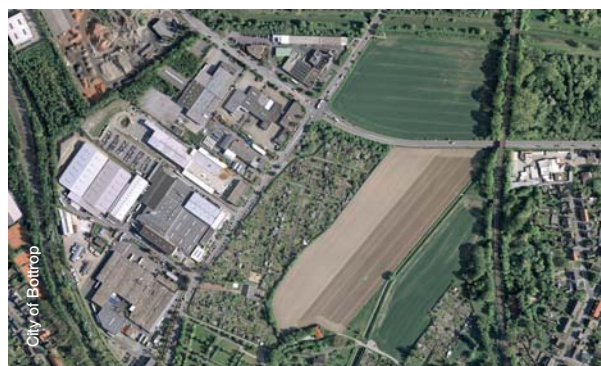
Le parc industriel de la Scharnhölzstraße
